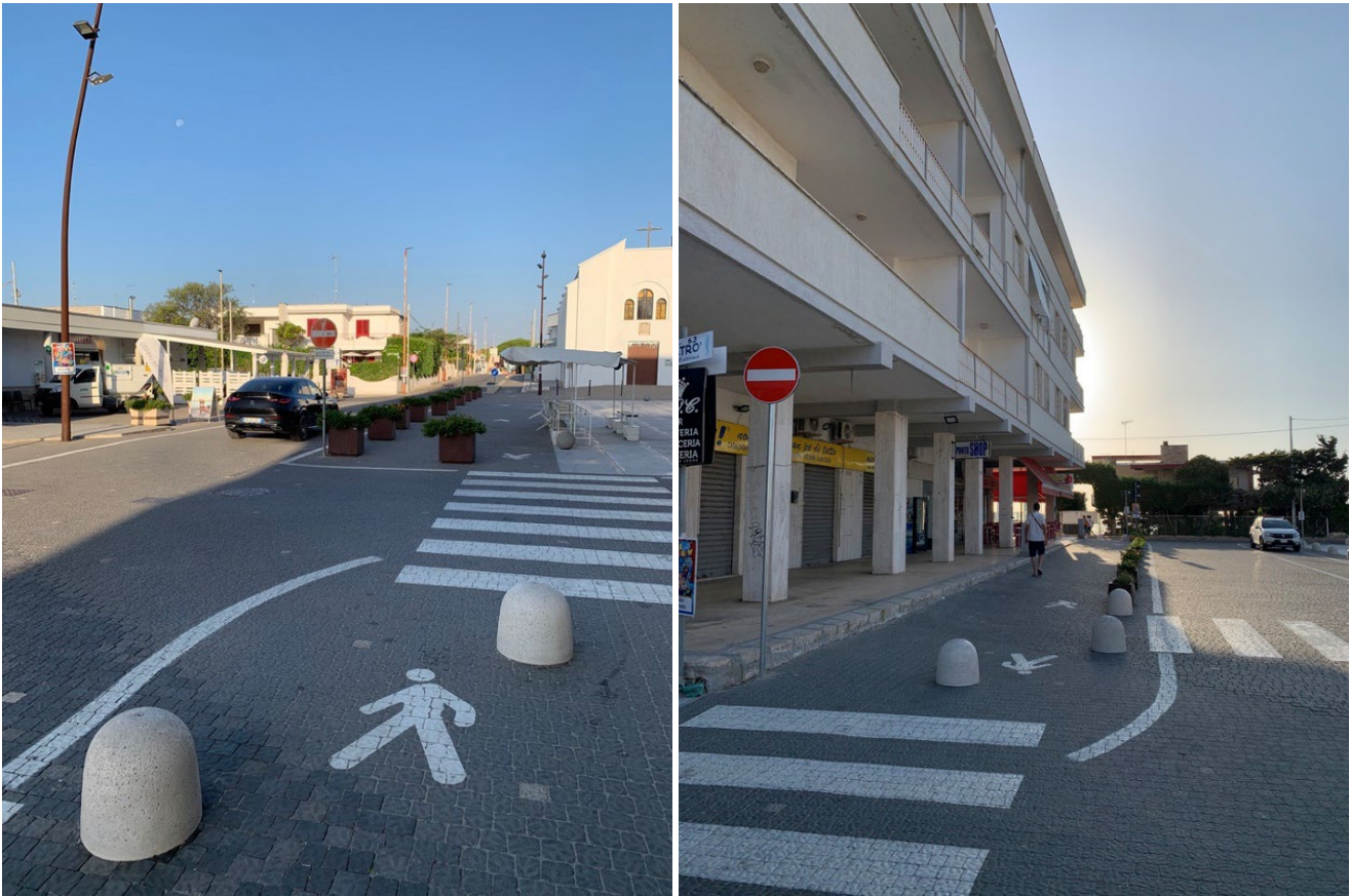
Figura 7-15: Esempi di protezione dei camminamenti a Torre dell’Orso (Melendugno)
